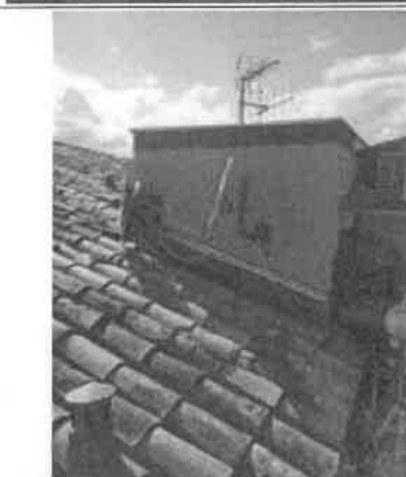
Photo n° PhA010 Localisation : Toitures - Toit_Terrasse_Sud Ouvrage : 1 - Couvertures, Toitures, Terrasses et étanchéités - Étanchéité de toiture terrasse Partie d'ouvrage : Colle Description : Colle Solin Localisation sur croquis : ZPSO-008
