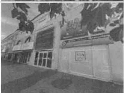
Photo n° PhA012 Localisation : Façade Ouest - Façade Ouvrage : 2 - Parois verticales extérieures et Façades - Façades lourdes y compris poteaux Partie d'ouvrage : Enduit extérieur (projeté, lissé ou taloché) Description : Enduit extérieur Localisation sur croquis : ZPSO-003
